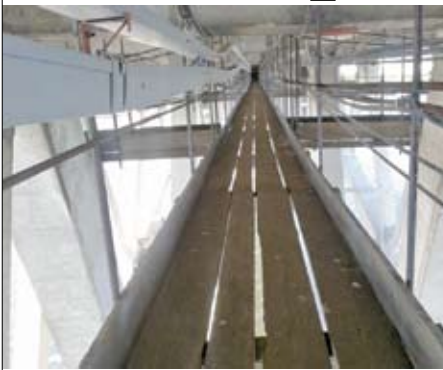
Смотровой ход под мостом
