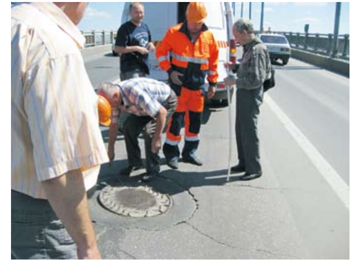
Специалисты осматривают сооружение
